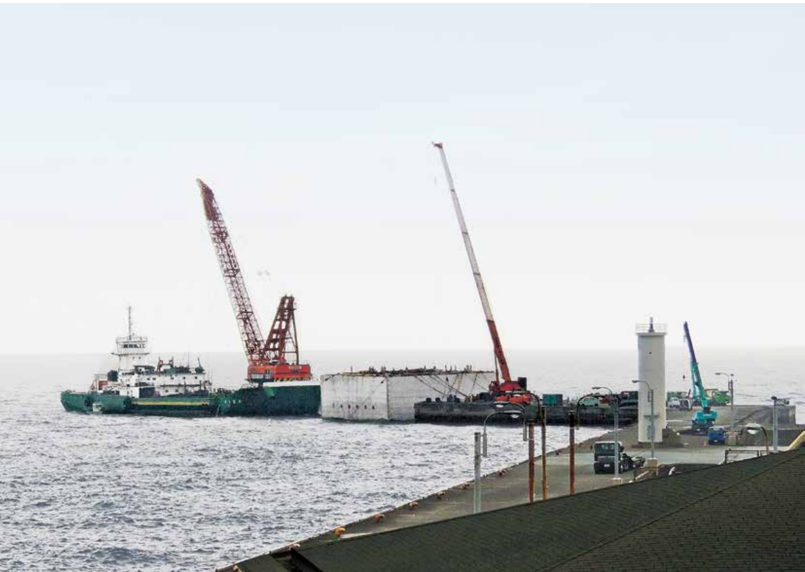
写真：三池港でのケーソン設置の様子 (平成28年度三池港防波堤建設工事)
