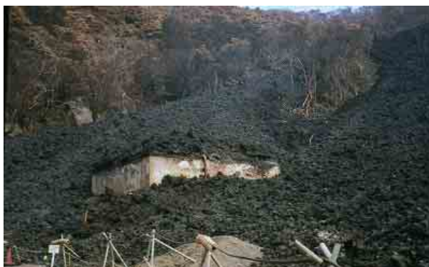
昭和58年 溶岩流に飲み込まれた阿古水道施設
