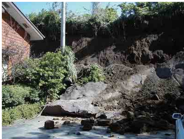
平成12年 噴火時の地震で発生したがけ崩れ
