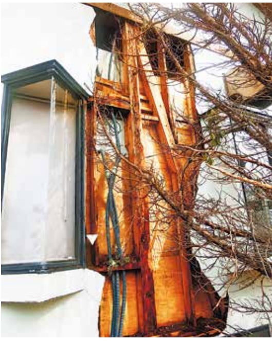
被害を受けた村有施設
